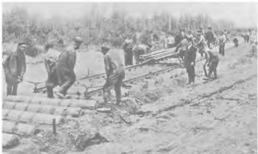
Строительство железной дороги в конце XIX в.
