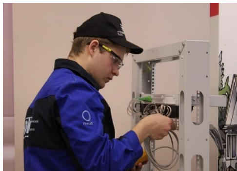
Рисунок 1 – Процесс подключения оптического кросса
